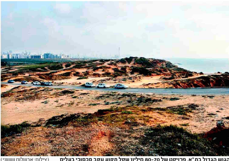
הגוש הגדול בת"א. פרויקט של 70-80 מיליון שקל תקוע עקב סכסוכי בעלים (צילום: אבשלום ששוני)
